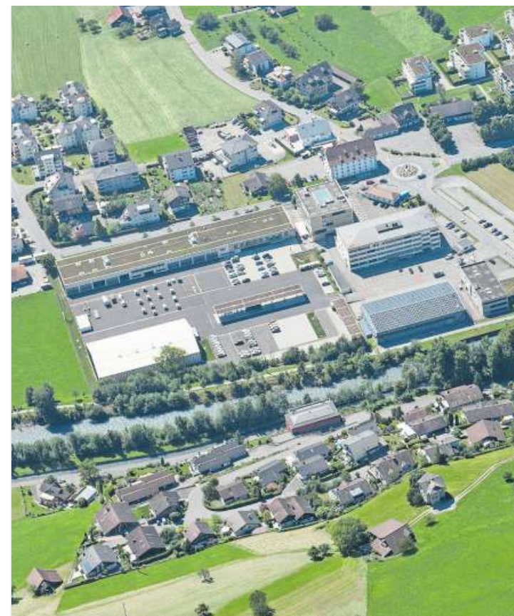
Die Halle soll auf der Wiese links vom bestehenden Kasernenareal zu stehen kommen (linker Bildrand). Bild: PD
