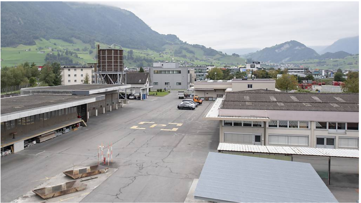
Das Areal Kreuzstrasse, auf dem der Kanton Nidwalden ein neues Sicherheitskompetenzzentrum bauen will. (Archivaufnahme). © Keystone / Urs Flueeler
