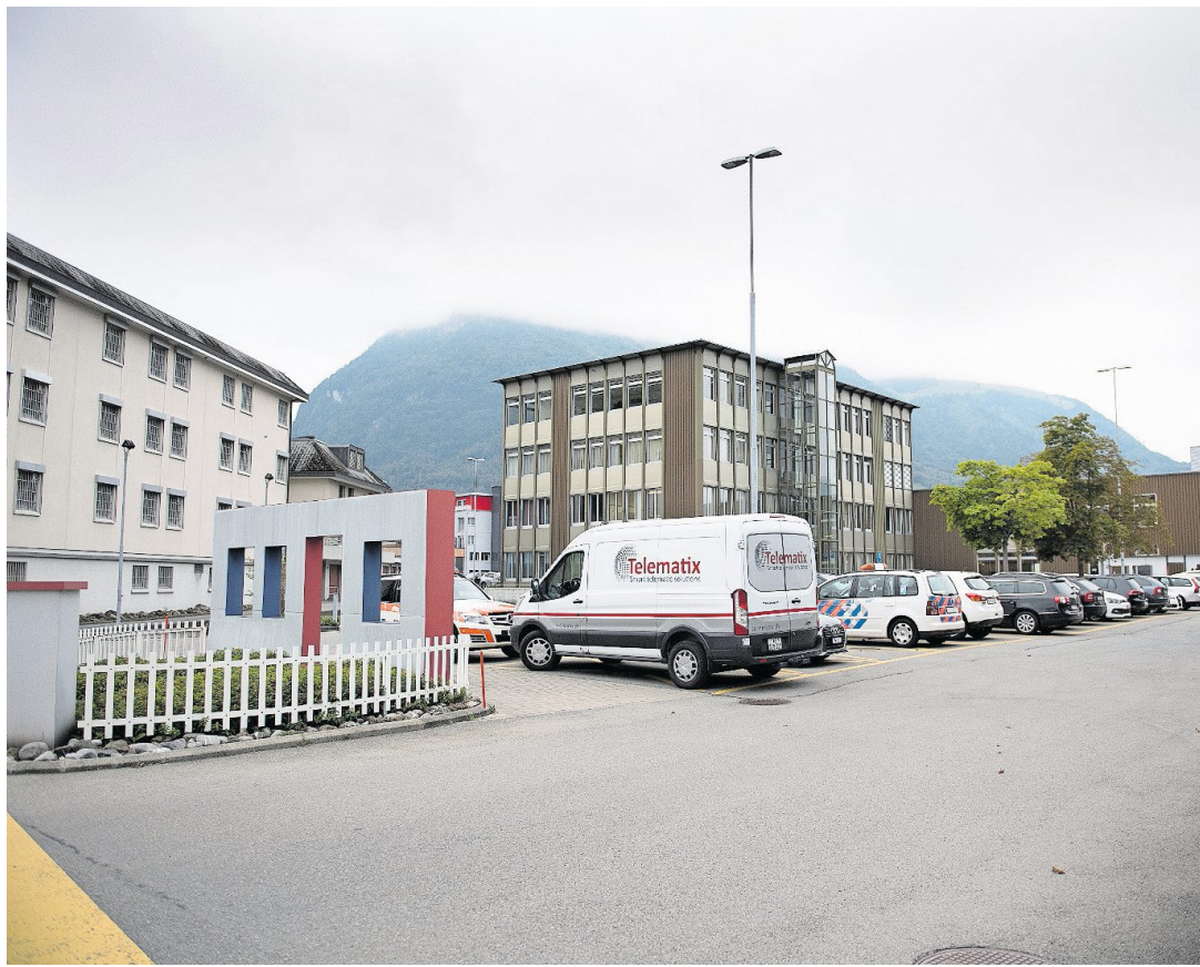
Auch das sanierungsbedürftige Gefängnis (links) und das Verwaltungsgebäude an der Kreuzstrasse sind Bestandteile der Testplanung. Bild: Corinne Glanzmann (Stans, 18. September 2019)
