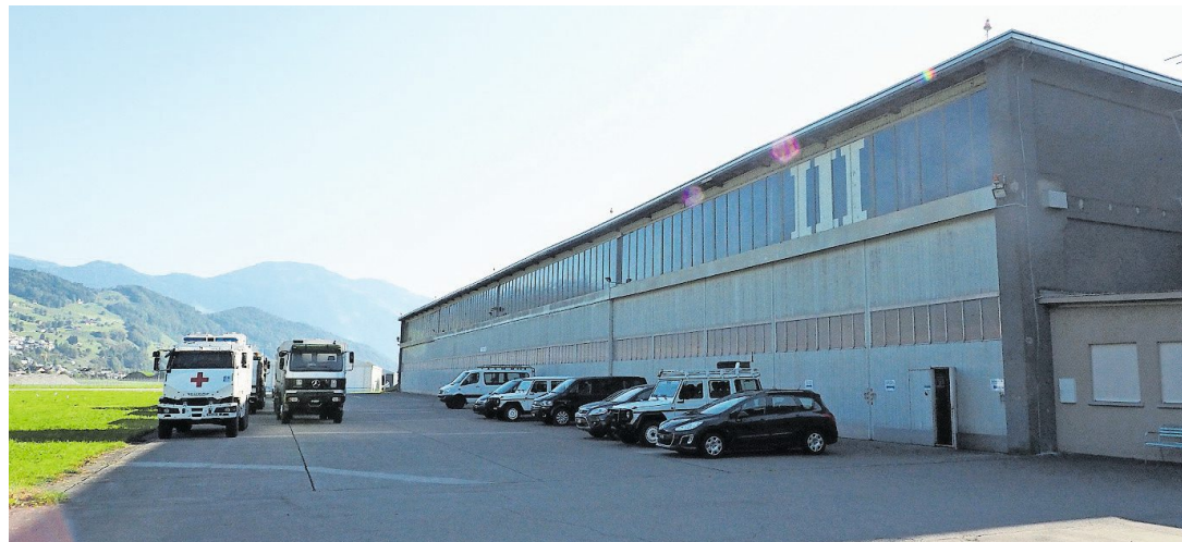
Die Halle 3 auf dem Flugplatz Buochs muss abgebrochen werden. Deshalb wollen Armee und Kanton den Ersatzbau Süd im Anschluss an das Kasernenareal des Militärs bzw. der Swissint realisieren. Bild: PD
